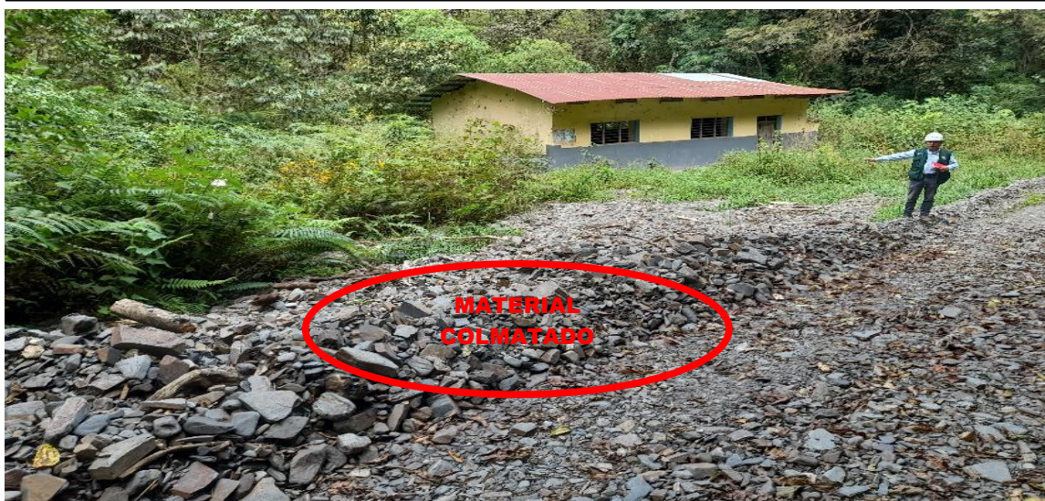
FIGURA N°03: PROFESIONAL DE LA ALA LA CONVENCION OBSERVA EL MATERIAL COLMATADO EN EL CAUCE DE LA QUEBRADA, CON UNA PROFUNDIDAD PROMEDIO DE 1.0 M. ESTO PROVOCA QUE DESBORDAMIENTO DEL RÍO SEA MAS INMINENTE.
