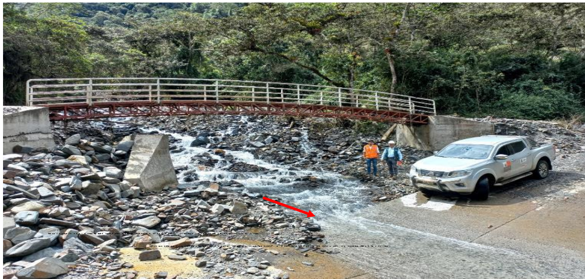
FIGURA N°02: MATERIAL COLMATADO EN EL CAUCE DE LA QUEBRADA, CON UNA PROFUNDIDAD PROMEDIO DE 1.0 M. ESTO PROVOCA QUE DESBORDAMIENTO DEL RÍO SEA MAS INMINENTE.
